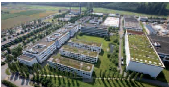
Roche Kaiseraugst (AG)
